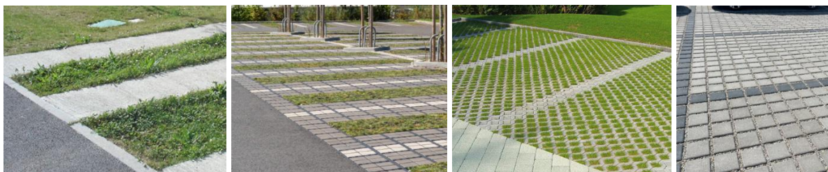
Exemples de revêtements perméables et/ou végétalisés
